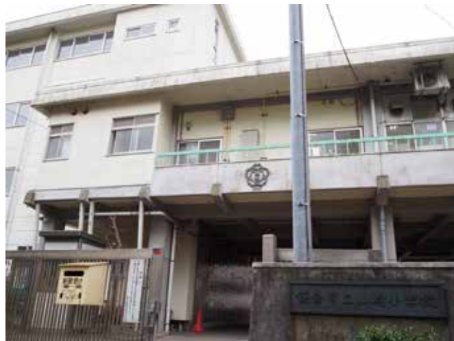
パイロット校の鎌倉市立山崎小学校
