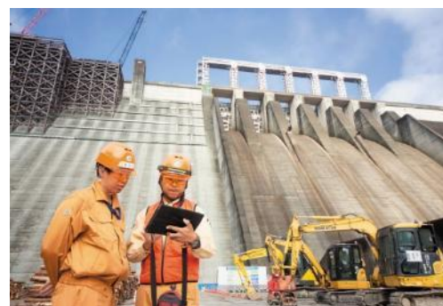
大林組による早明浦ダムの工事現場
